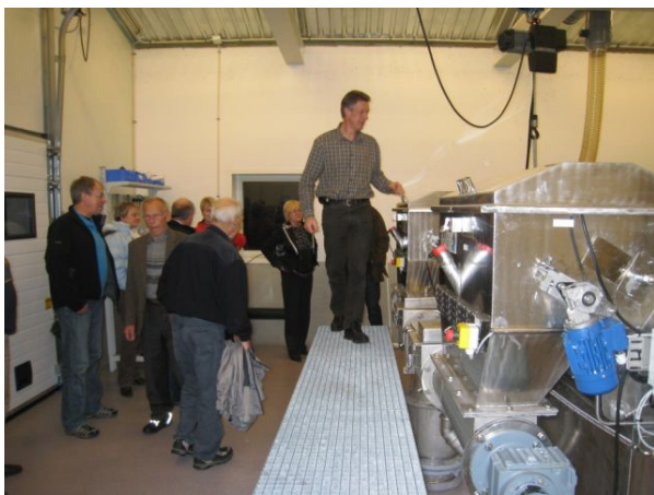
Renseanlegget er topp moderne. Stig forklarer
